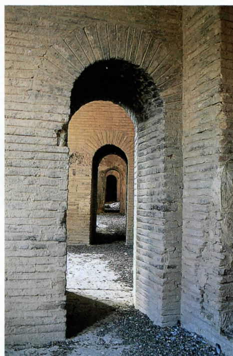
Galería practicable, del segundo cuerpo del templo, que formaba parte de la red de pasadizos y estancias militares, conectando con la Torre.
