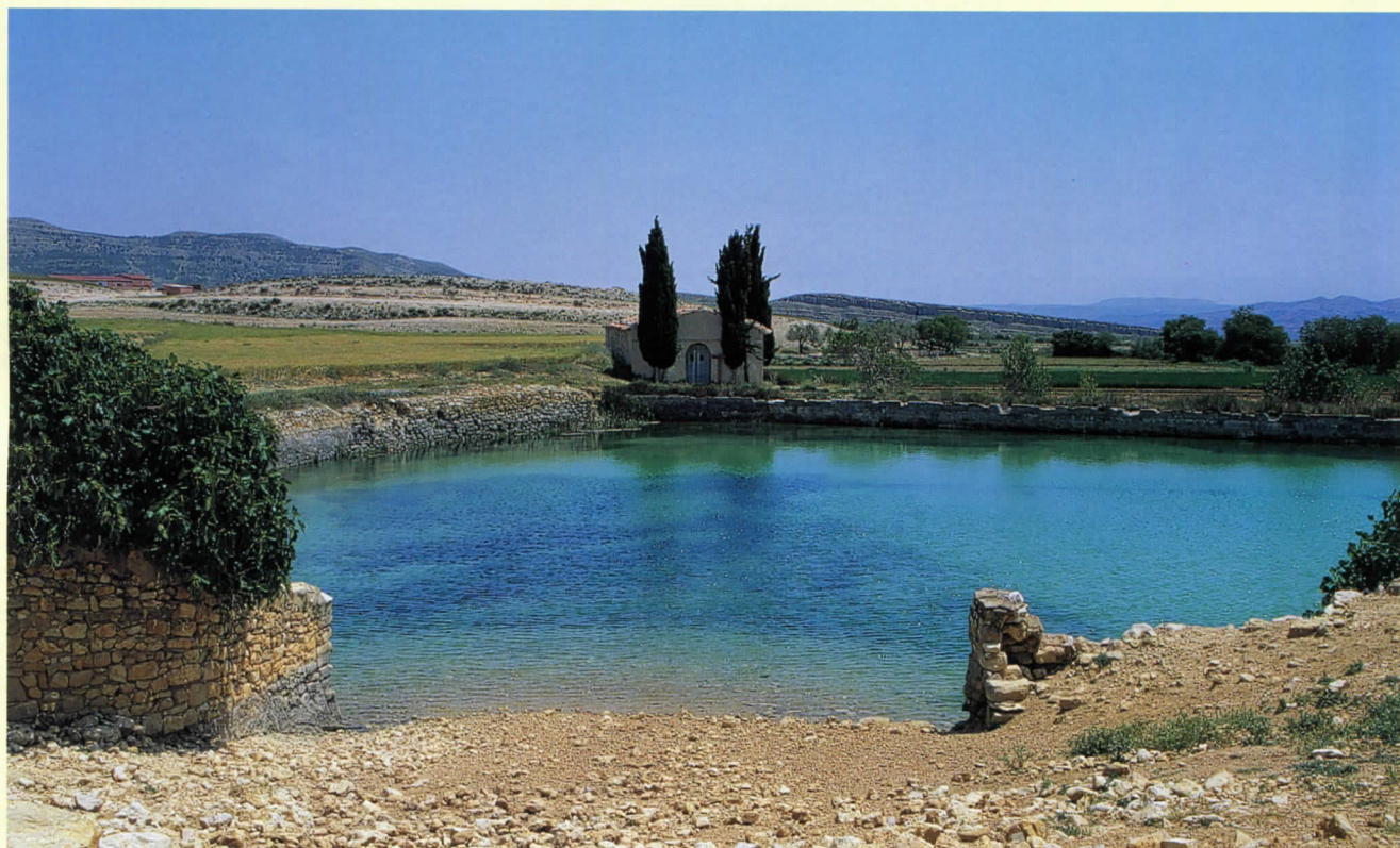
La ermita de San Miguel y la balsa en proceso de llenado. A la izquierda, donde se aprecia la higuera y el muro de piedras se localiza la boca de entrada al caño. El acceso a la balsa que se aprecia en la fotografía se utiliza para su limpieza, extracción de lodos y llenado de las cubas de agua por regantes y agricultores. Foto J. C. Gordillo
