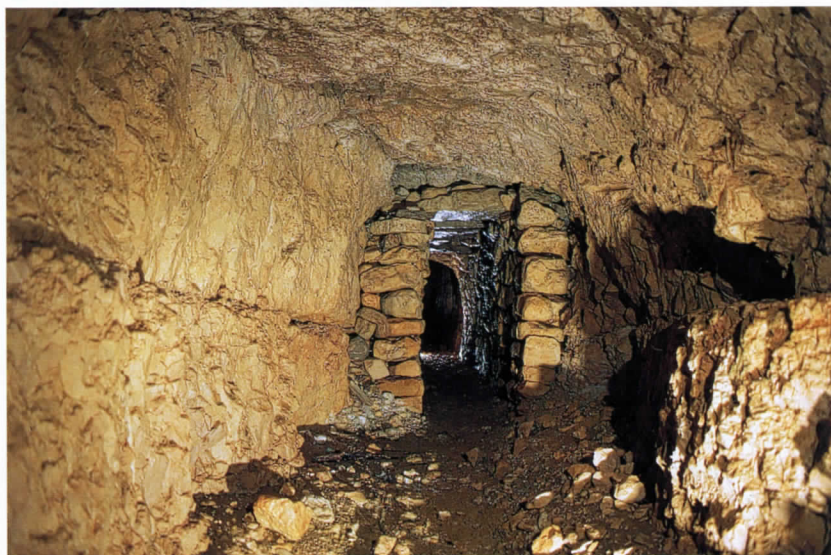
Tramo medio del caño. Se aprecian los muretes laterales de piedra y las losas que sustentan el techo.
