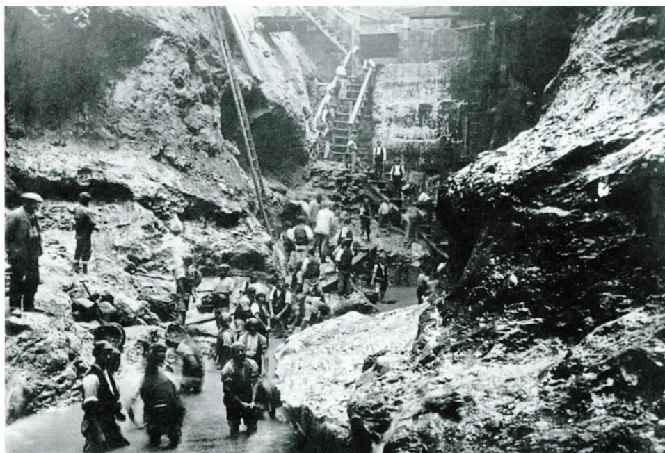
▼ Trabajos en el fondo del cuenco de cimentación a 20 metros bajo el nivel del río, 1912.
