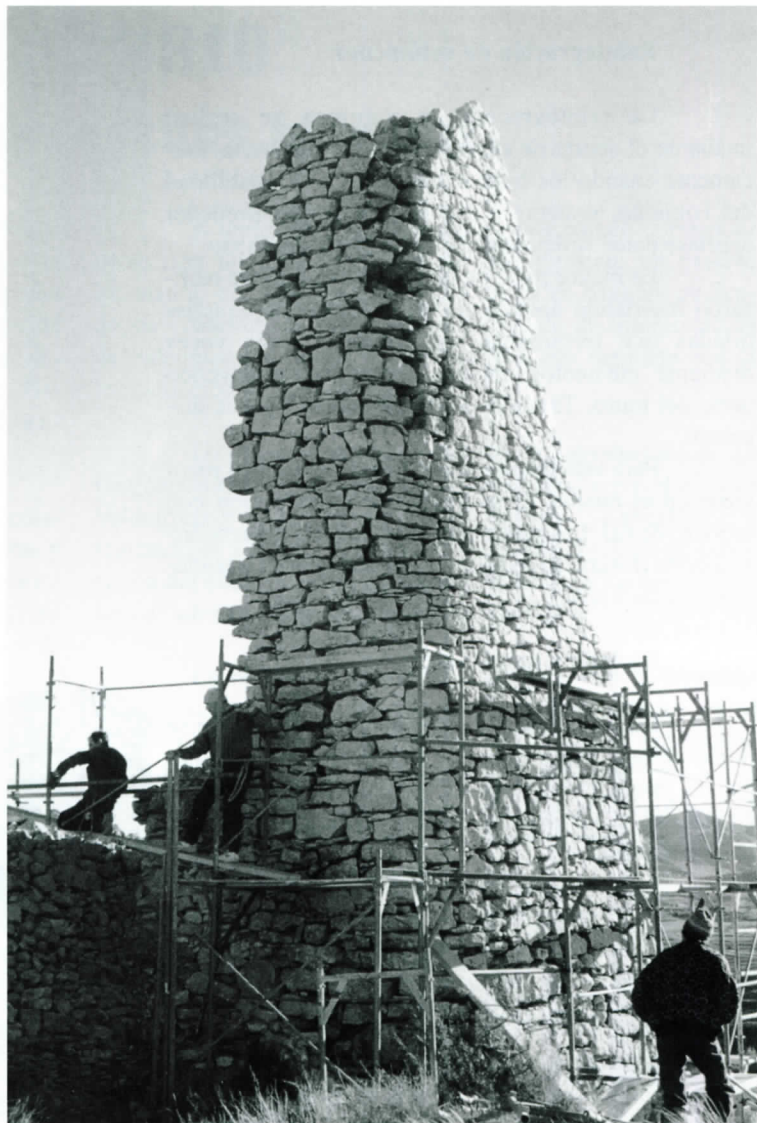
Vista de la Torre A desde el Norte, antes de la intervención
