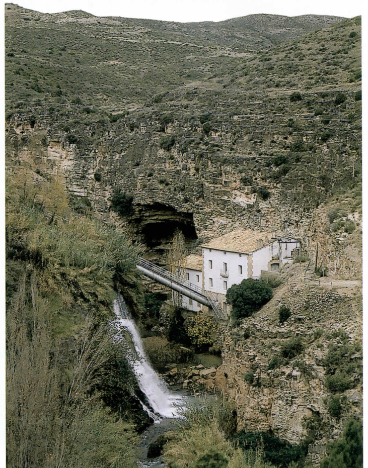
Central de Rivera y cascada originada por las aguas sobrantes provenientes de la acequia de la canal.
