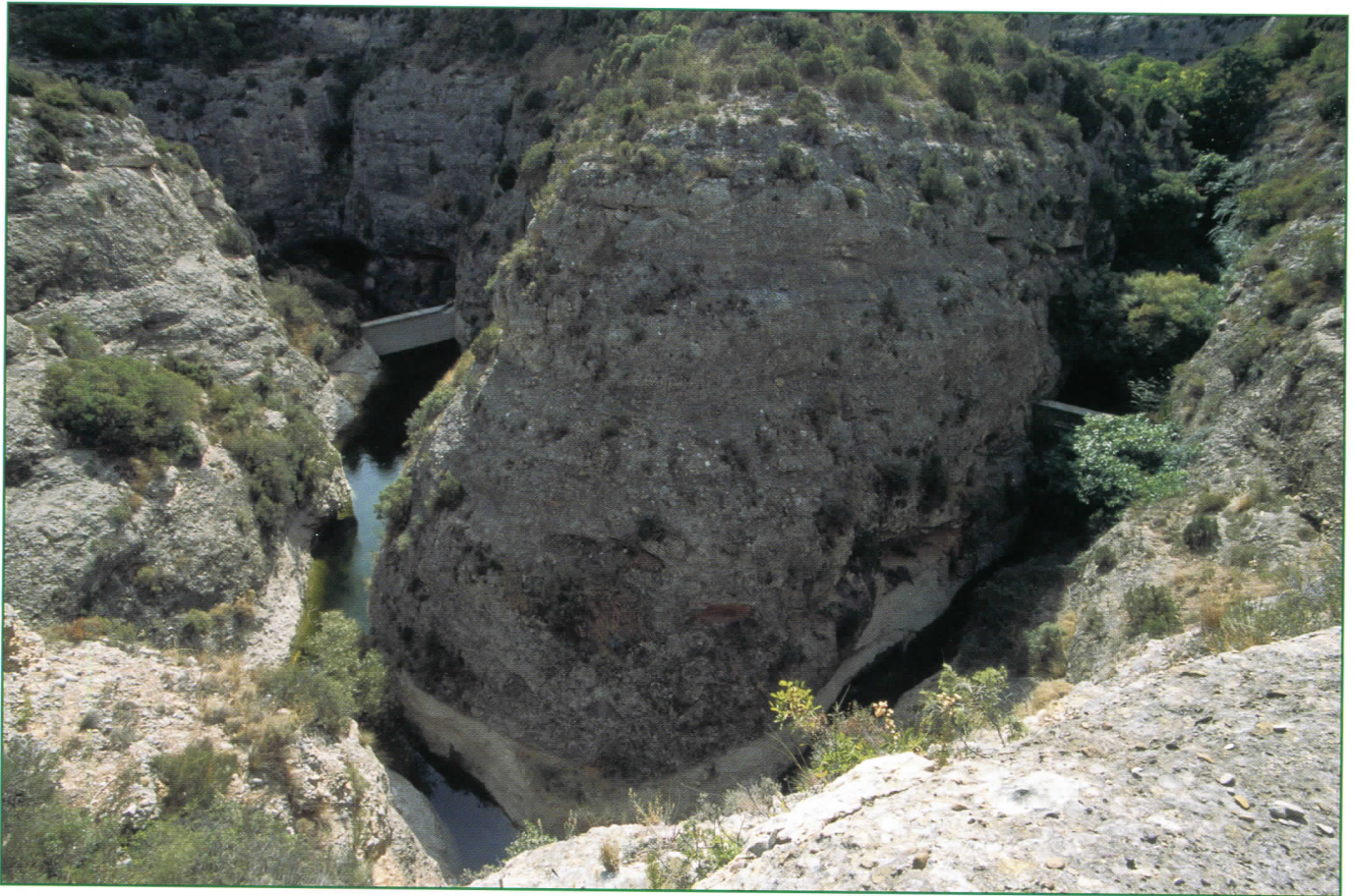
Vista del recodo del barranco de Valdoria, en cuyos estrechos se construyeron las presas de contención de sus aguas. Por la margen izquierda se localiza el paso articulado como vía ferrata en el primer tercio del siglo pasado.
