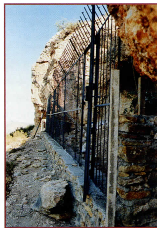
Trabajos de realización del murete de mampostería e instalación de la reja de protección en 1994.
