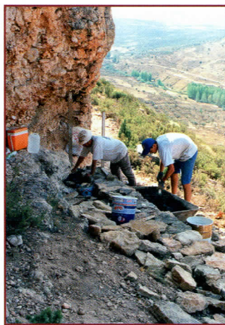
Trabajos de realización del murete de mampostería e instalación de la reja de protección en 1994.
